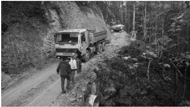
Bau der Forststrasse Twäriberg
