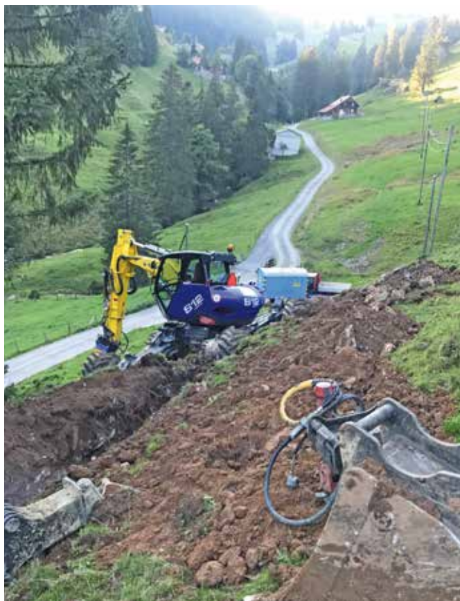
Neue Wasserleitung Chrut – Klösterli
