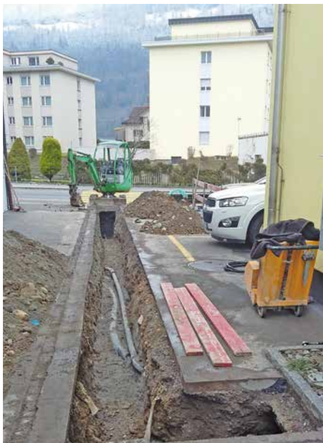
Neue Wasserzuleitung Verwaltungsgebäude
