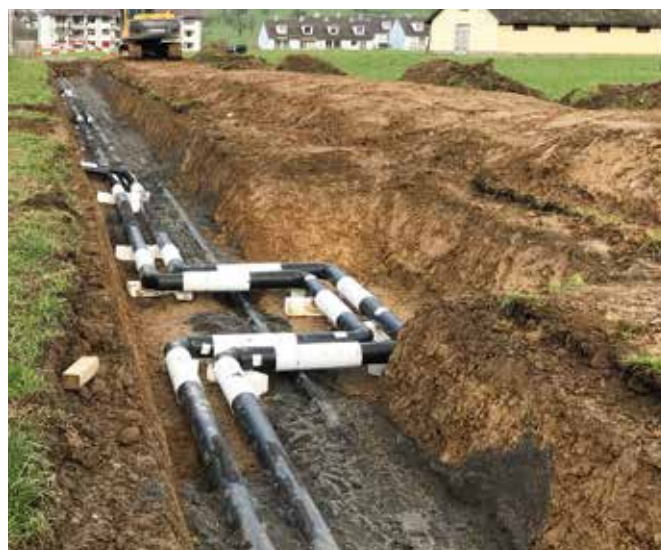
Verbindung Fernwärmenetz Tramweg zur Breitgasse
