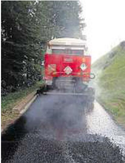
Mit einer speziellen Maschine wurde die Rufibergstrasse mit Bitumen bespritzt.
