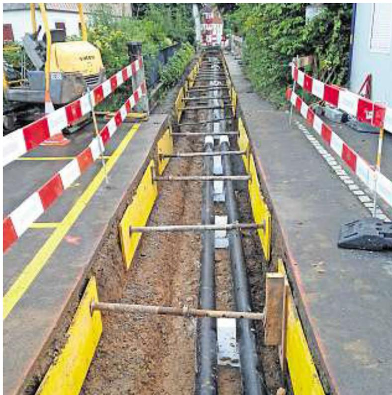
Im Fernleitungsgraben werden zwei Rohre (Vorlauf und Rücklauf) für die Versorgung der Wärmebezüger eingebaut. Bilder: zvg
