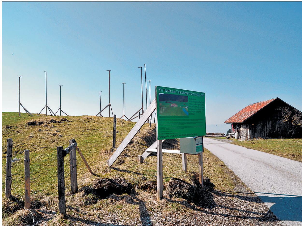
Die alte Schirmhütte (rechts) auf dem Rufiberg soll einem Neubau weichen. Das Baugespann zeigt, wo das künftige Bergrestaurant mit Naturseeli und Biotop entstehen soll.
