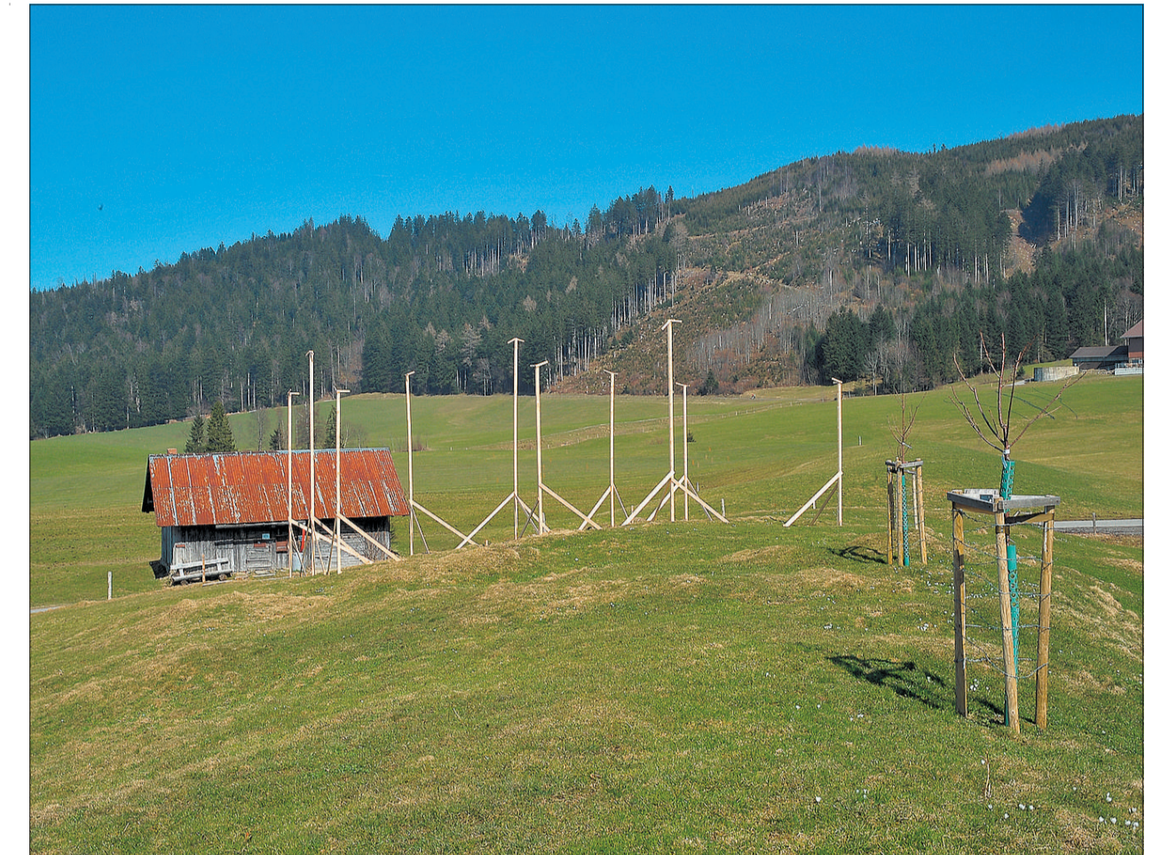
Die alte Schirmhütte auf dem Rufiberg soll einem Neubau weichen. Bild Erhard Gick
