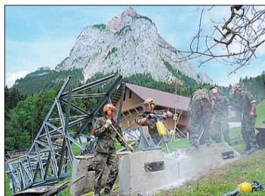
Die Armee bei den Abbrucharbeiten der Seilbahn. Bild Erhard Gick
