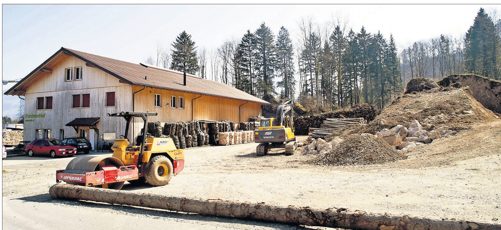
Die Erweiterung des UAK-Forsthofes in Goldau hat begonnen.
