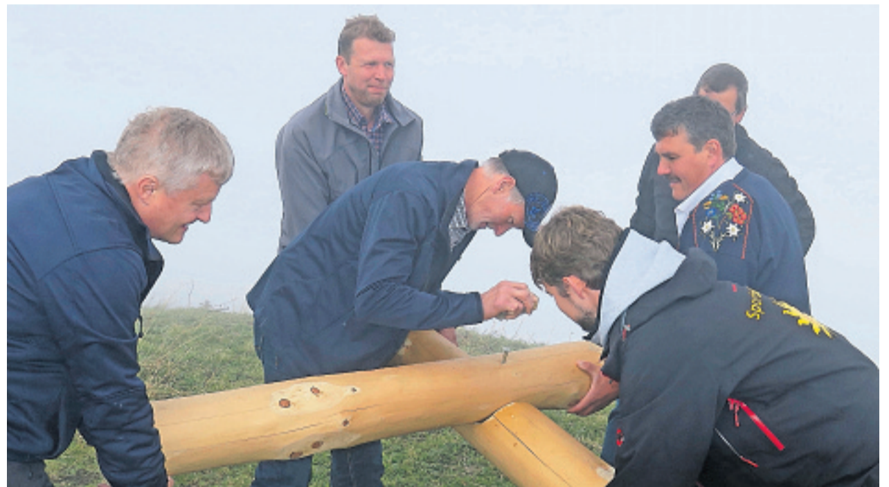
Auf dem höchsten Froni-Gipfelpunkt wurde das neue Kreuz fertig montiert.
