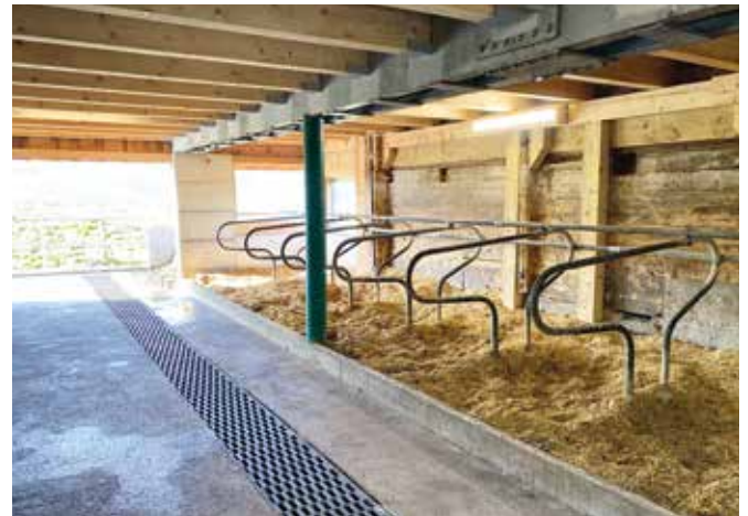
Umbau Alpstall Kaltenbrunnen
