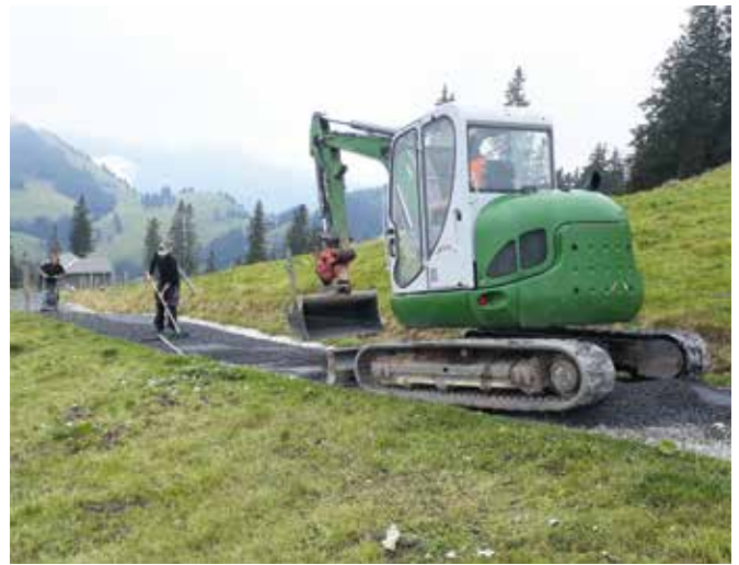
Instandstellung Alpweg Schwändi – Kulmhütte
