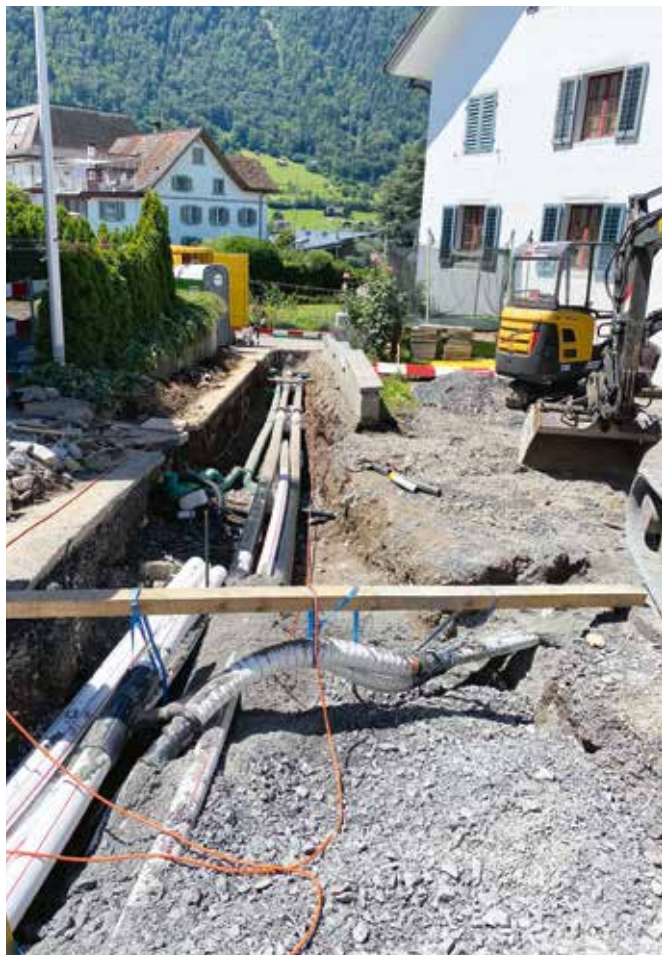
Einbau der Vor- und Rücklaufleitungen
