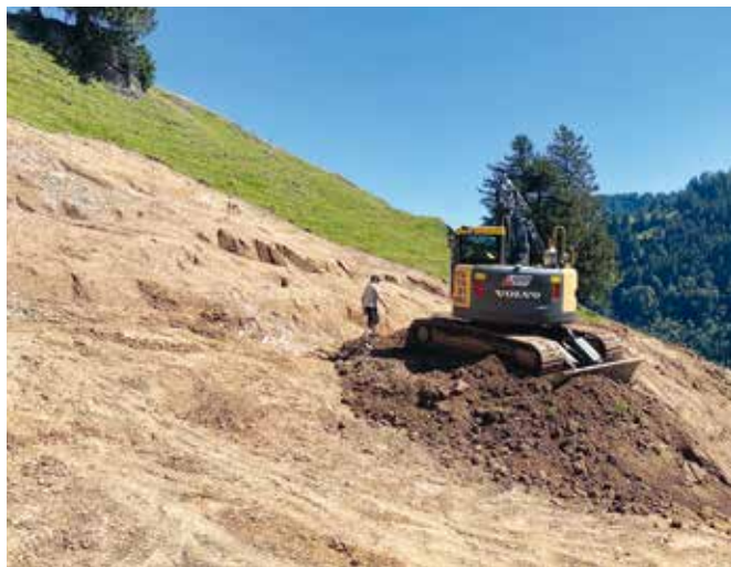
Kugelfangsanierung des ehemaligen Rigischiessen
