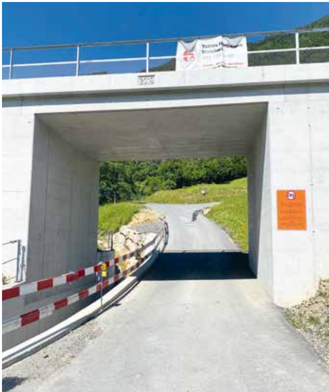
Neubau Unterführung Rufibergstrasse
