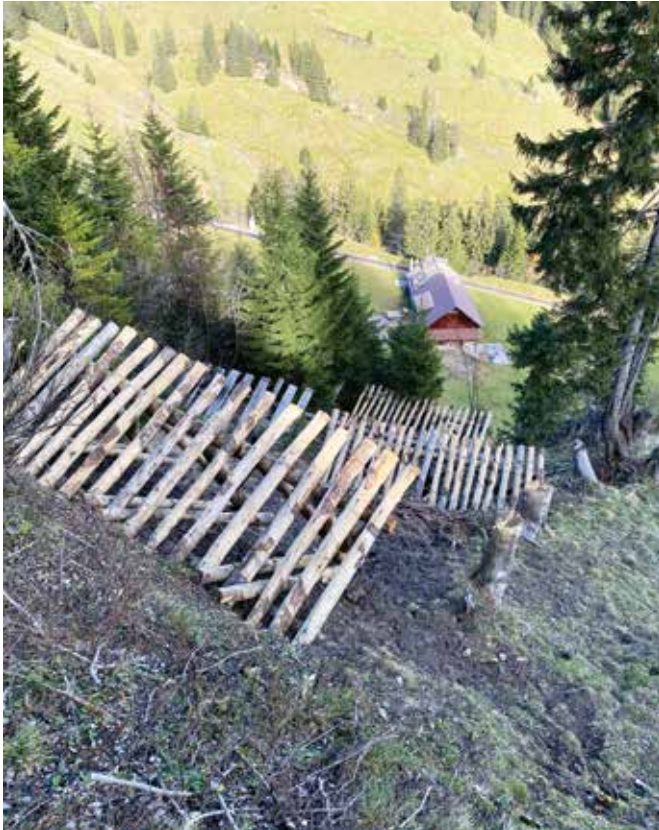
Neue Lawinenerwerke Wölfertschen
