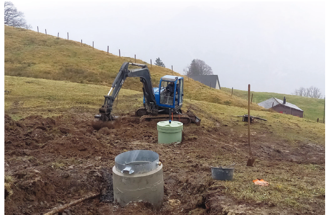
Instandstellung Wasserversorgung Kaltenbrunnen
