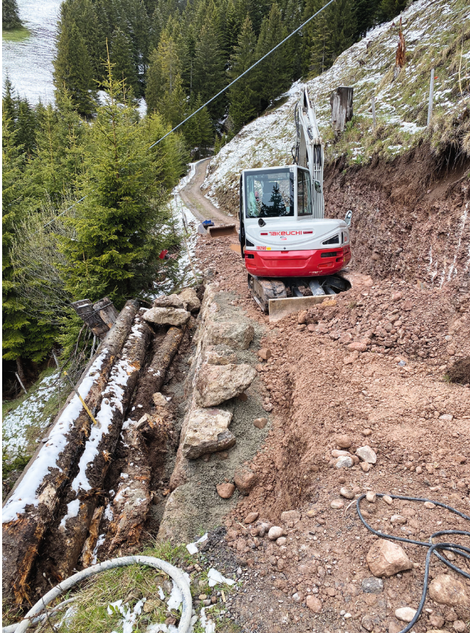
Neue Blocksteinmauer Alpzufahrt Trieb
