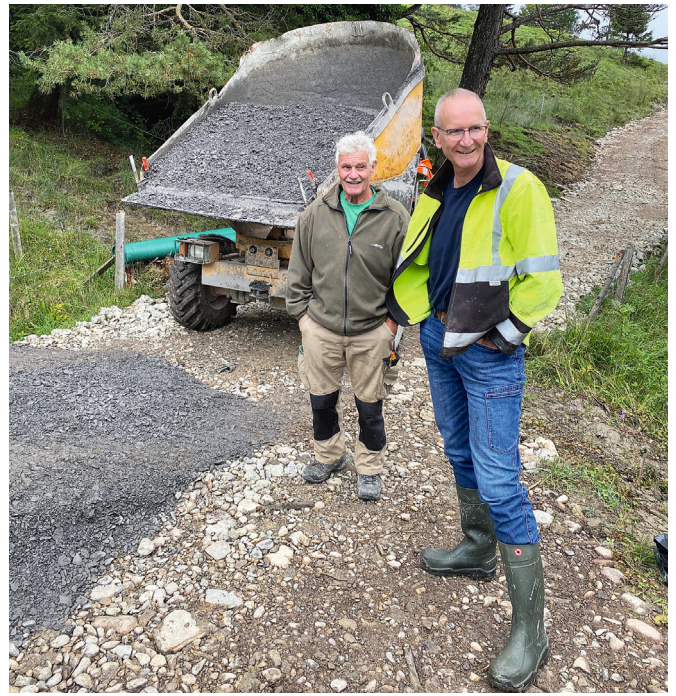
Fronarbeit am neuen Verbindungsweg Spitzibüel – Ochsenboden
