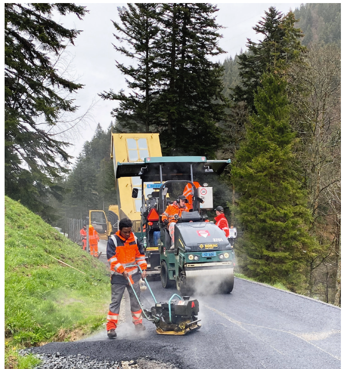
Belagsarbeiten Fruttli – Klösterli
