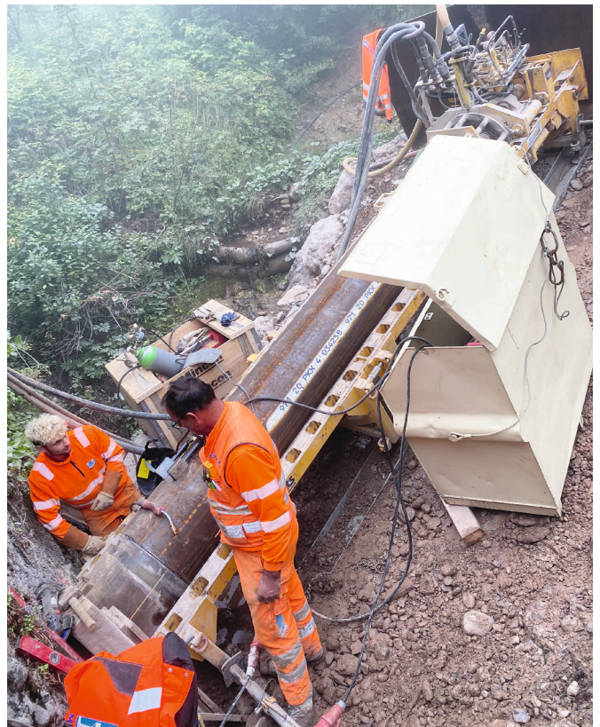
Bohrarbeiten für neuen Durchlass Unterstetten
