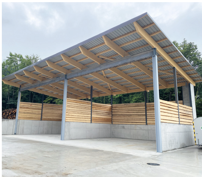
Neue Schnitzelhalle beim Forstwerkhof Goldau
