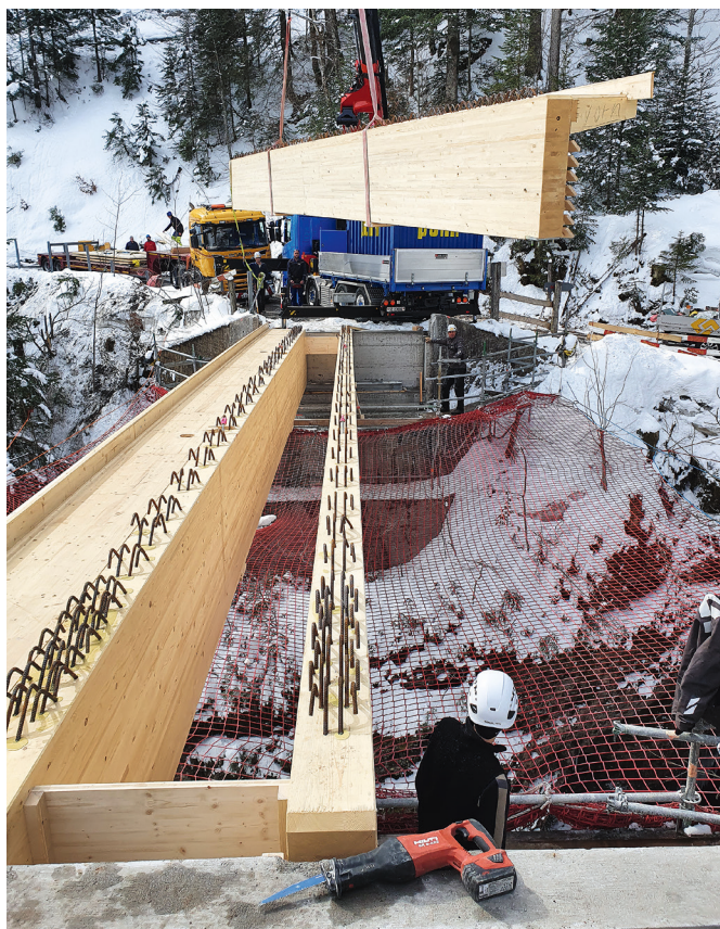
Einbau Holzträger Rigiabobel Brücke
