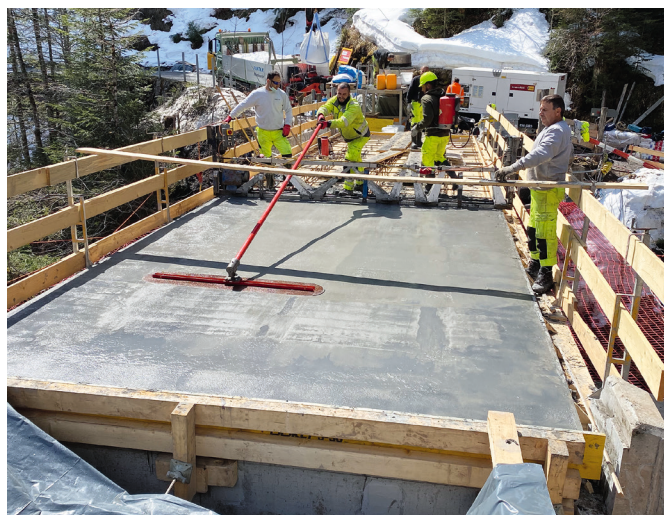
Einbau UHFB Fahrbahnplatte
