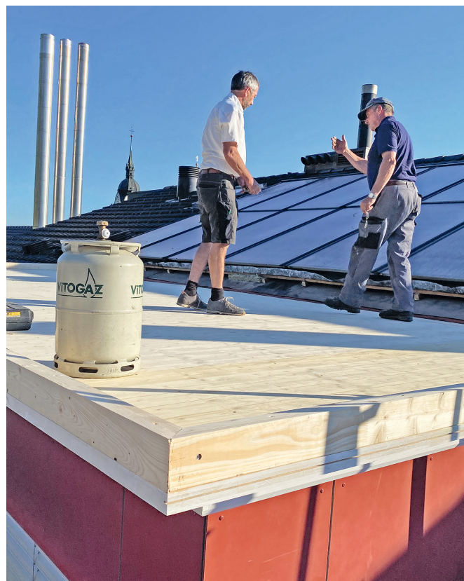
Dachsanierung Mehrfamilienhaus Schulweg 12
