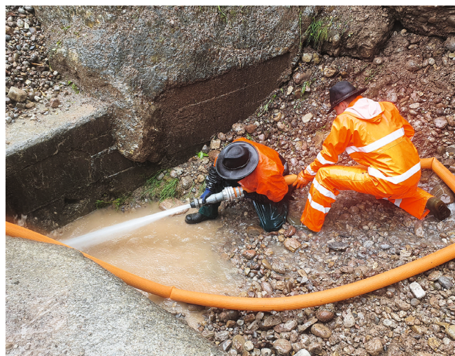
Forstmitarbeiter beim Spülen von Strassendurchlässen
