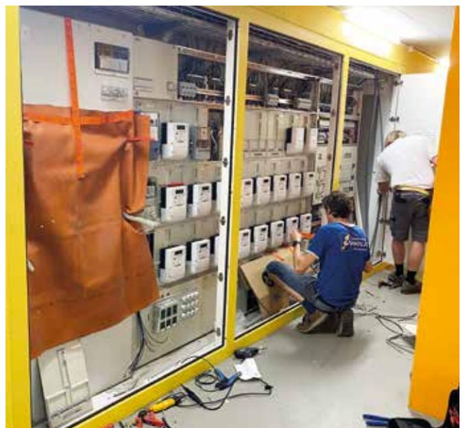
Elektroladestation Tiefgarage und Einbau neue Stromzähler.
