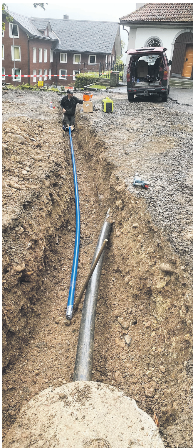
Erneuerung Trinkwasserleitung Klösterli
