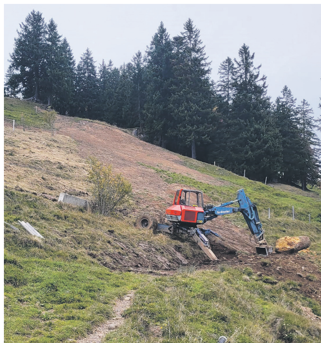
Abschlussarbeiten Instandstellung Hangrutsch Schild
