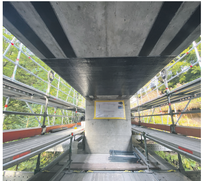
Verstärkung der Malchusbrücke
