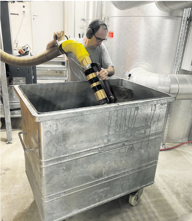
Asche absaugen Heizzentrale Arth
