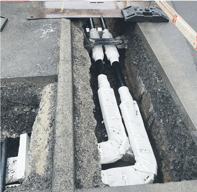
Neuer Fernwärmeanschluss Rigiweg
