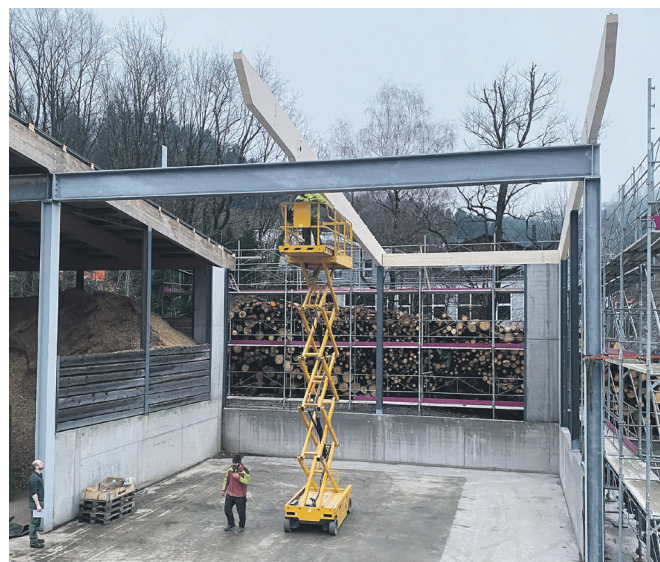
Anbau Schnitzelhalle Goldau
