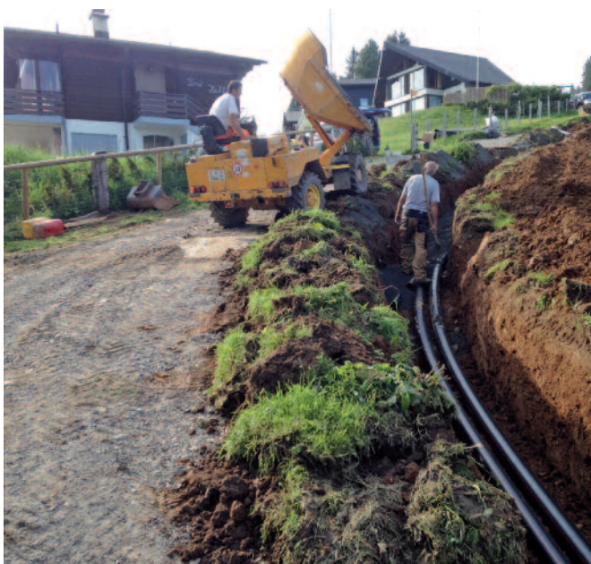
Werkerschliessung Baugebiet Rigi First.
