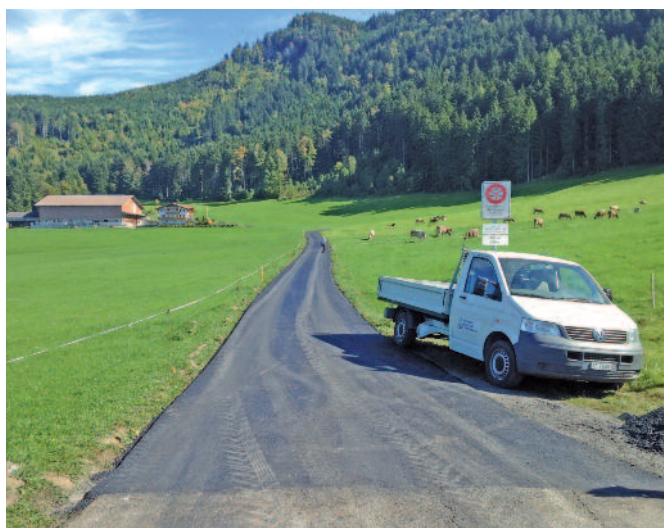
Neuer Deckbelag Dürrenboden.
