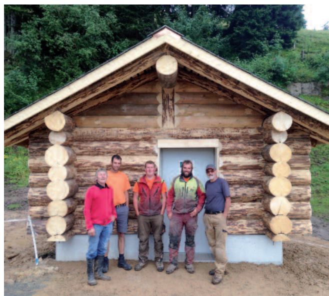
Neubau WC Hüttli Unterstetten.
