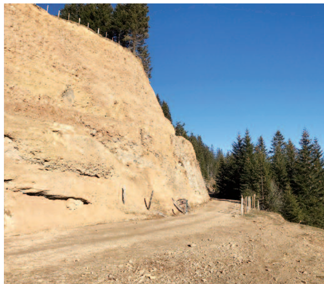
Panoramastrasse nach Felssicherung im Bereich Elend.
