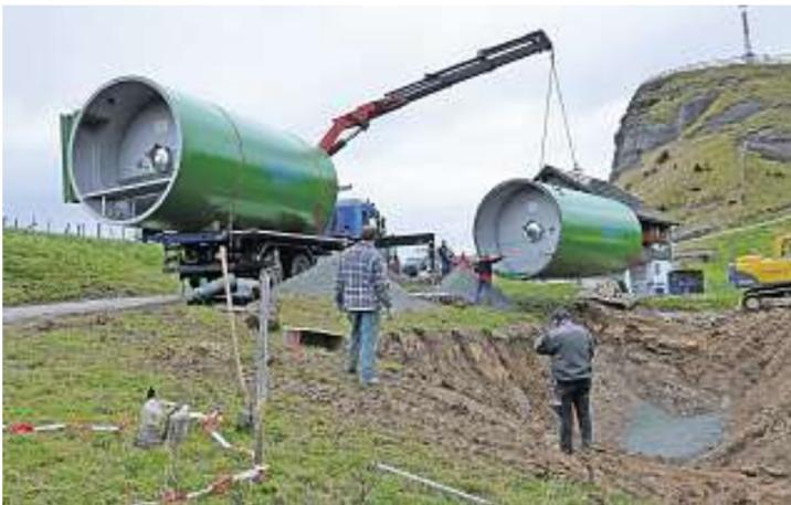
Das in zwei Teilen angelieferte Reservoir wird in die vorgesehene Baugrube versetzt.
