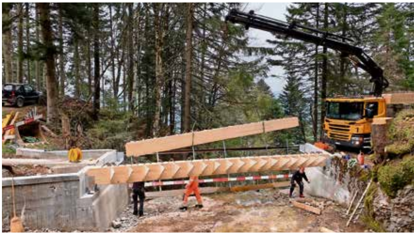
Vier Brettschichtholz-Träger werden versetzt.
