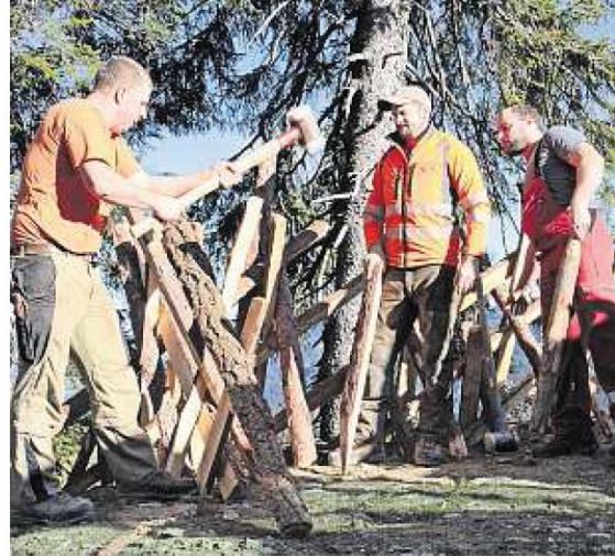
Felix Beeler (von links), Severin Nigg und Julian Salt von der UAK beim Errichten einer Ecke des Zauns: eine besonders knifflige Stelle. Bilder Nadine Annen
