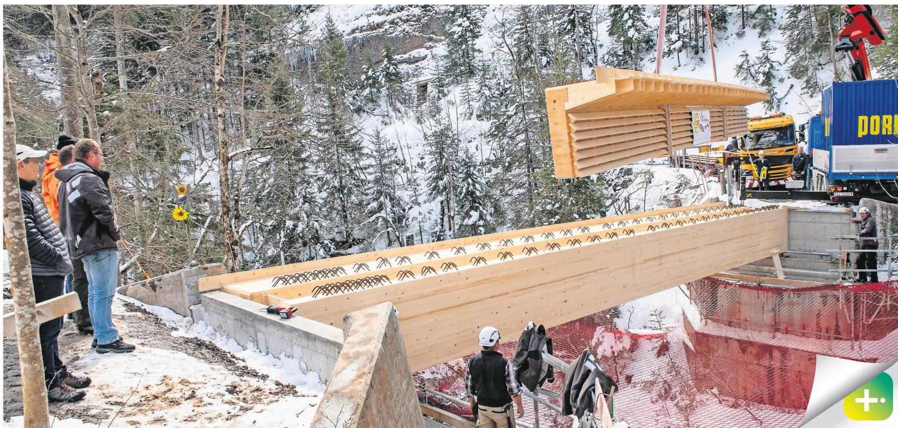
Zwei Brückenelemente sind bereits gesetzt, jetzt erfolgt der Einbau des letzten Holzträgers in einen vorgefertigten Betonsockel.
