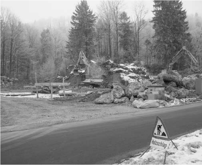
Stand der Baustelle Forstwerkhof Mitte Februar 06
