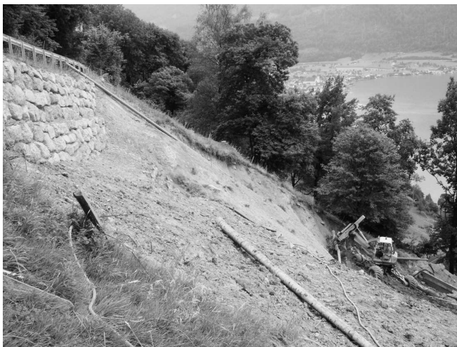
Verbauungsarbeiten Rufibergstrasse im Bereich Untereggen
