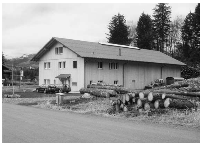
Die neue Werkhalle
