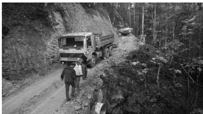
Bau der Forststrasse Twäriberg
