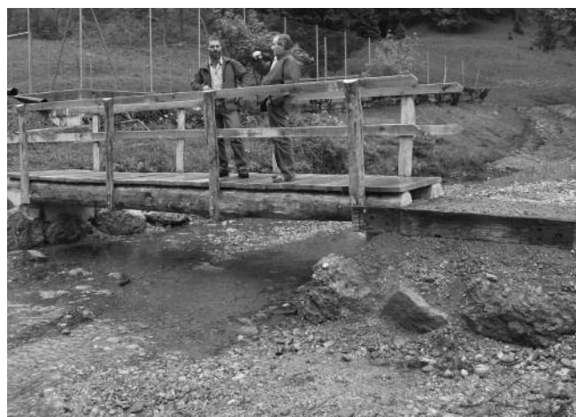
Der neue Fussgängersteg beim Kulmbach auf Rigi Klösterli
