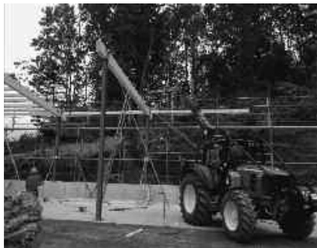
Bau Unterstand Brennholzlager
