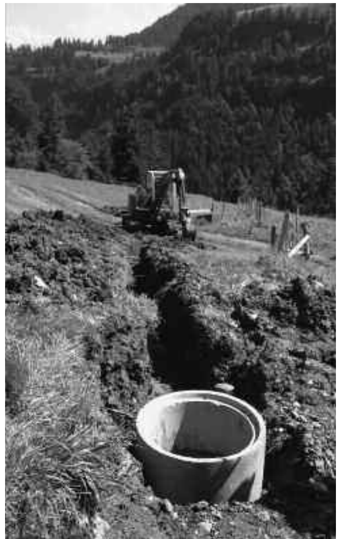
Instandstellung Wasserversorgung Guggli mit dem neuen Raupenbagger
